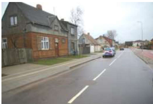
Kopskats uz vērtējamo Objektu no Pļavu ielas puses
